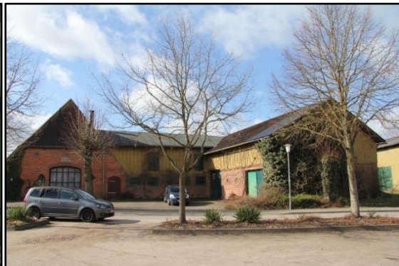
Gebäudebestand Reimerscher Hof
